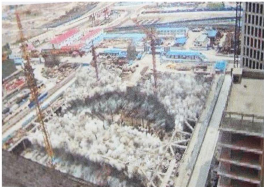
爆破拆除内支撑实景图
