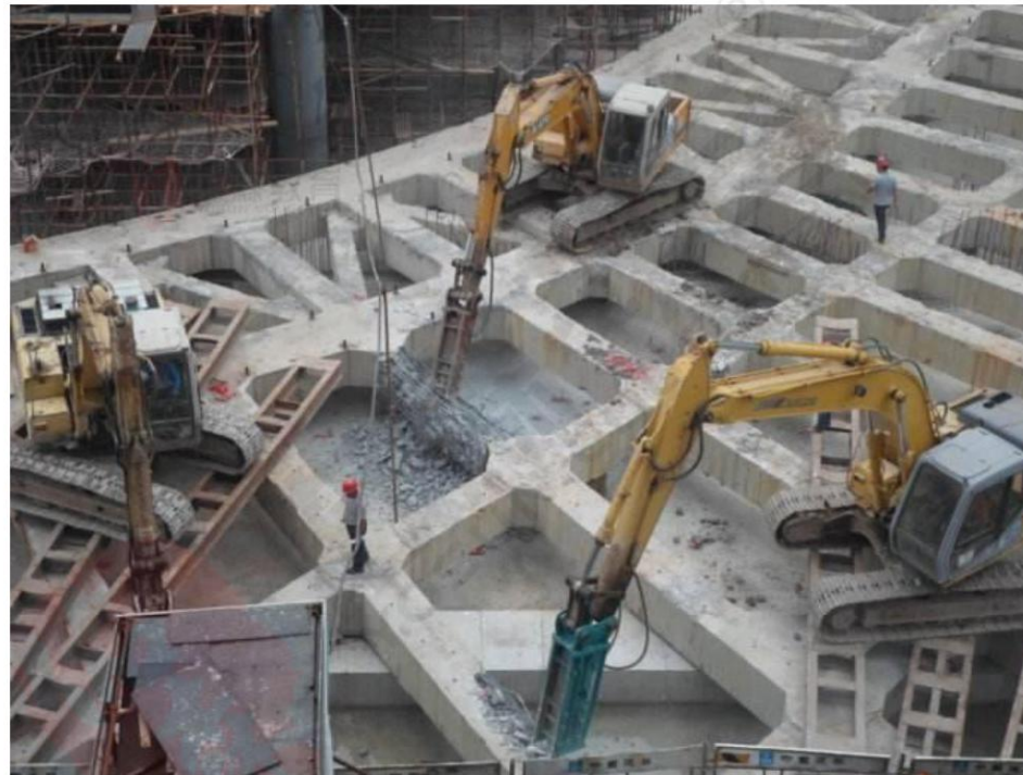
机械破碎拆除
