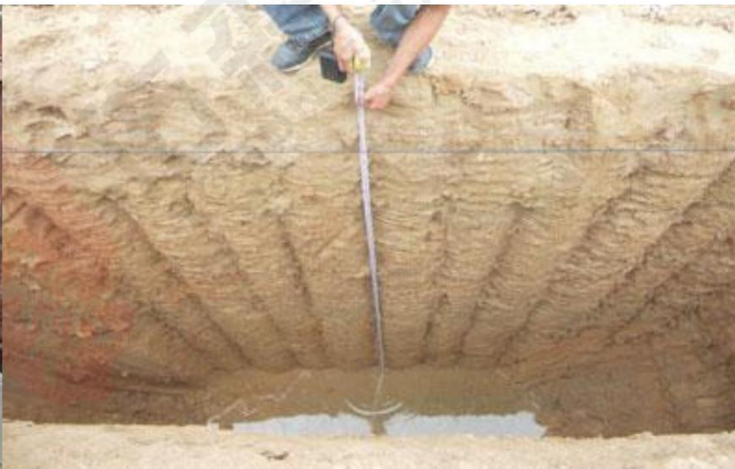
水泥土搅拌桩
